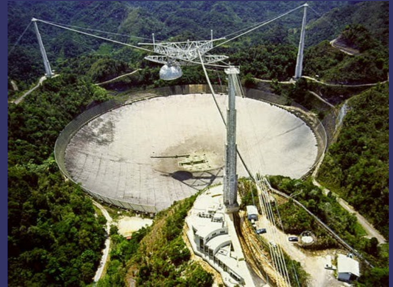
El mayor radio telescopio del mundo se encuentra en Arecibo, Puerto Rico y tiene un diámetro de 305 m
