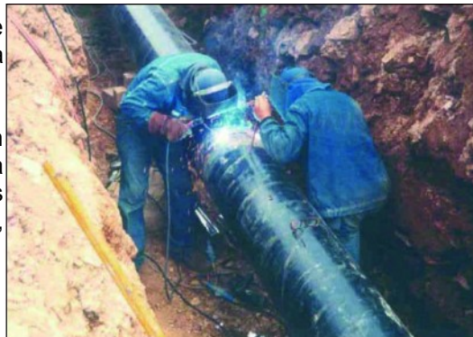
Obras de instalación dun gasoduto
