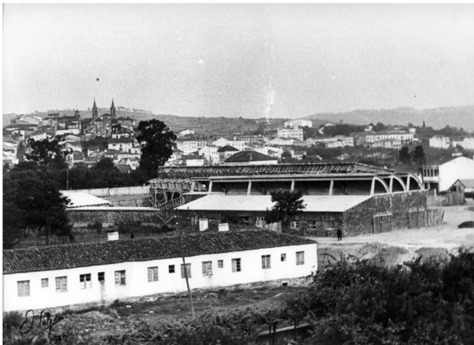
Antigo edificio do Instituto en construción.
