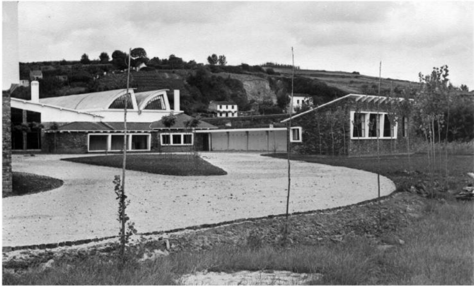
Vista parcial do antigo edificio do Instituto «Francisco Aguiar». En primeiro termo a Biblioteca, ó fondo a Sala de Profesores e Porche de acceso con gardería de bicicletas.
