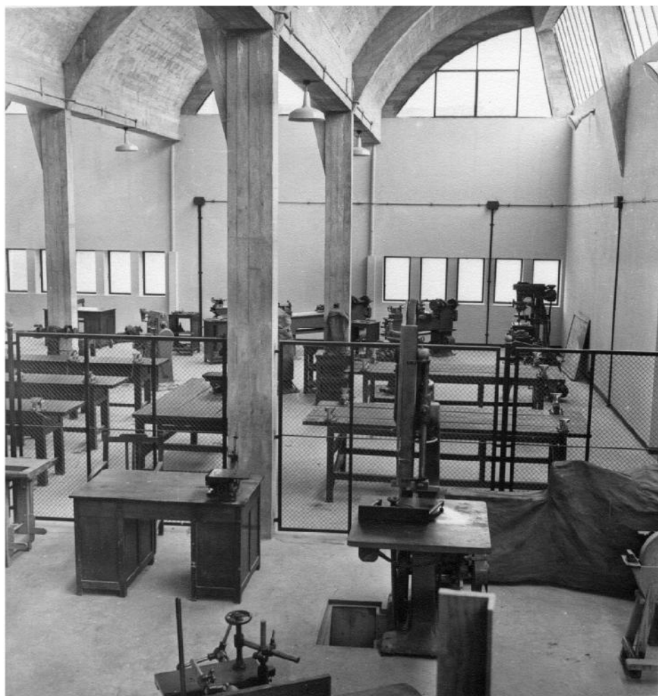
Vista parcial dos talleres de carpintería e mecánica.
