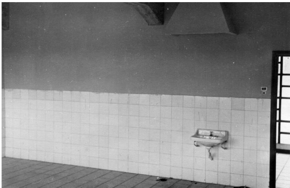
Local destinado a laboratorio de Química (detalle do mesmo).
