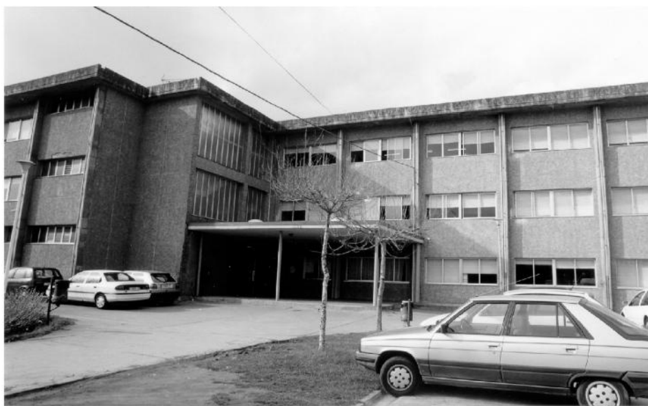
Entrada do actual edificio do Instituto «Francisco Aguiar».
