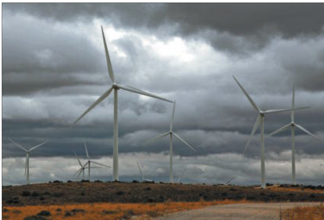
Aerogeneradores en el parque eólico Maranchón IV de Iberdrola en Guadalajara. / ISAAC. F. CALVO
