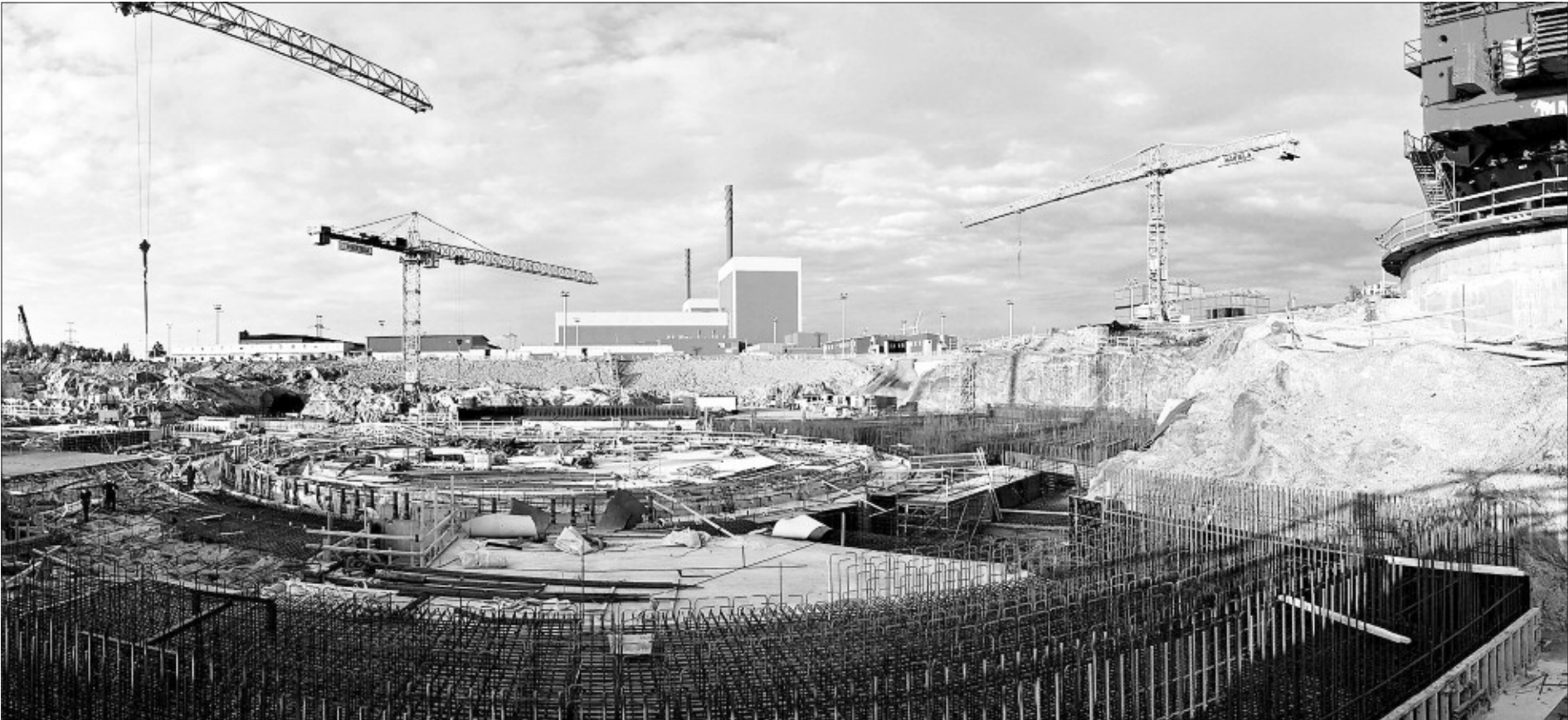
Construcción del reactor de la central nuclear de Olkiluoto3. / ASSOCIATED PRESS
