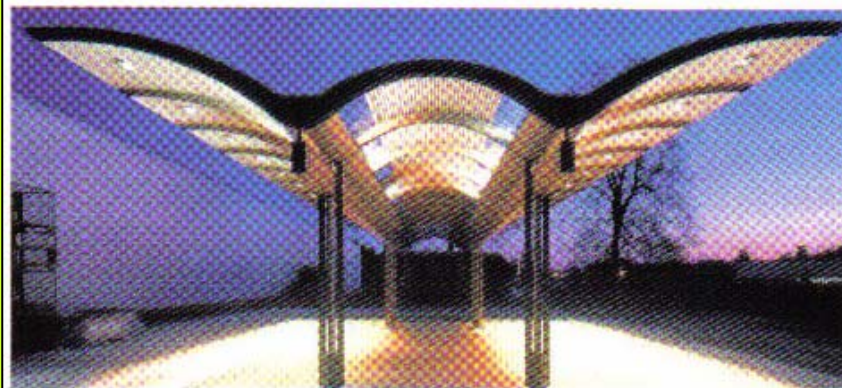
Figura 1.4: Energía fotovoltaica en una parada de autobús durante la noche. Fuente: Atlantis, Suiza.
