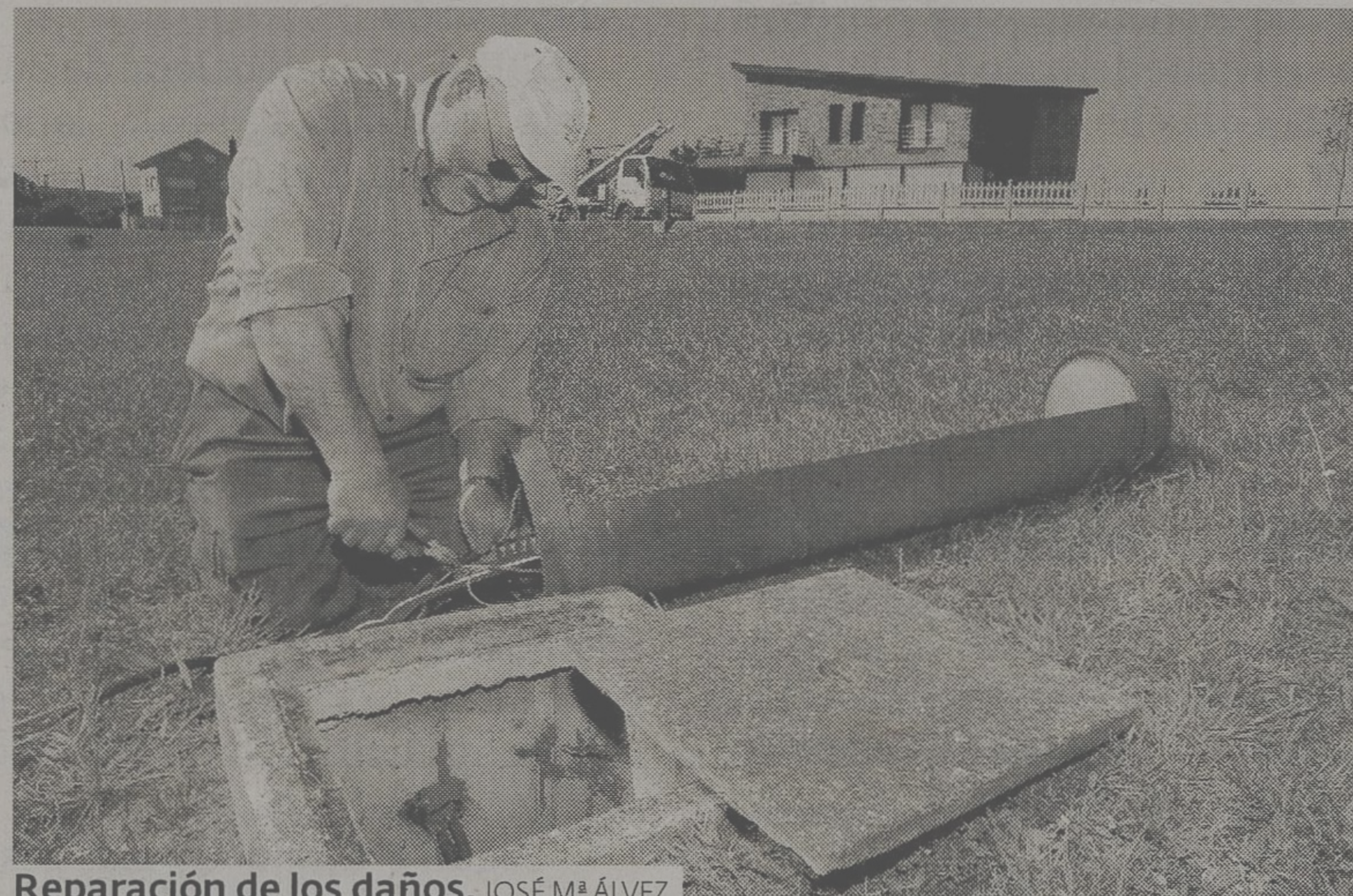
Reparación de los daños. JOSÉ Mª ÁLVEZ
